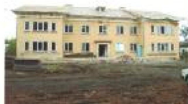
Капитальный ремонт 2010 год
